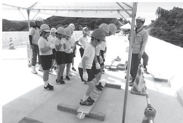
出前講座で勉強した工事現場を見学 (新沖田川橋 PC 上部工事現場で橋の強さについて体験)
