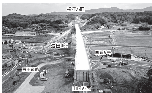
遠田 I C 周辺の道路改良工事の様子 (令和 7 年 2 月)
