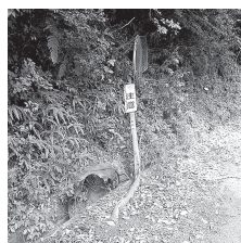
カーブミラーの損傷
