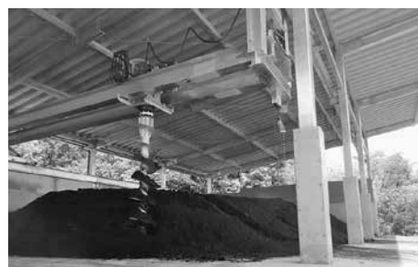
堆肥を攪拌する高圧エア-粉碎堆積発酵装置
