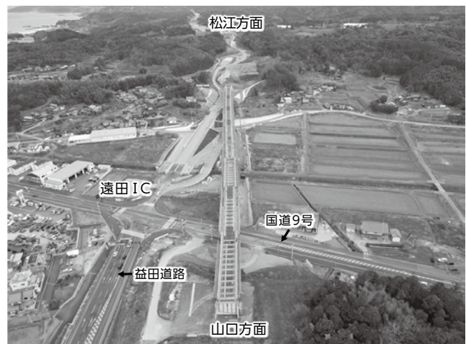
遠田IC周辺の道路改良工事の様子 (令和6年2月)
