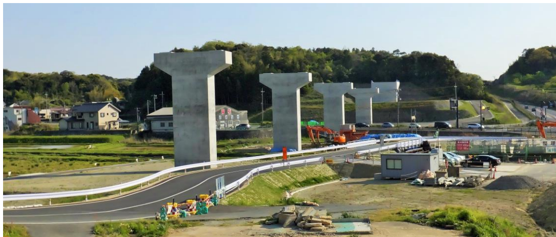
【 三隅・益田道路 遠田 IC 付近の施工状況 】
