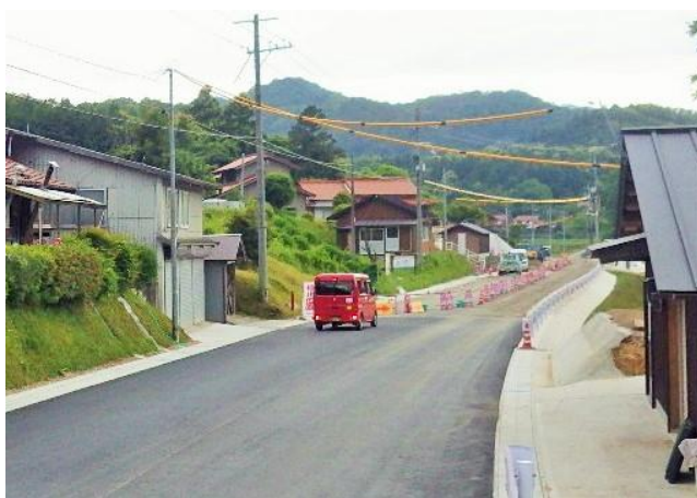
【 左：一般県道美濃地石見横田 停車場線の施工状況 】
