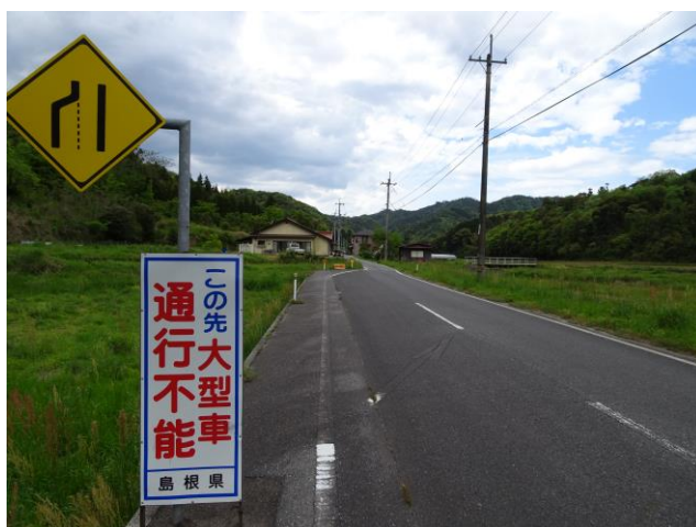
【 右：一般県道益田津和野線 未改良区間の状況 】
