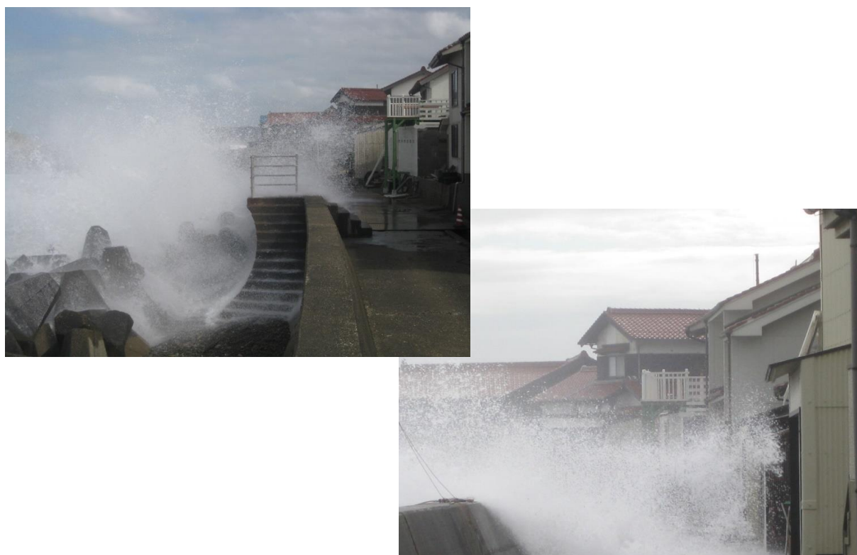
【 小浜海岸における越波の状況 】
