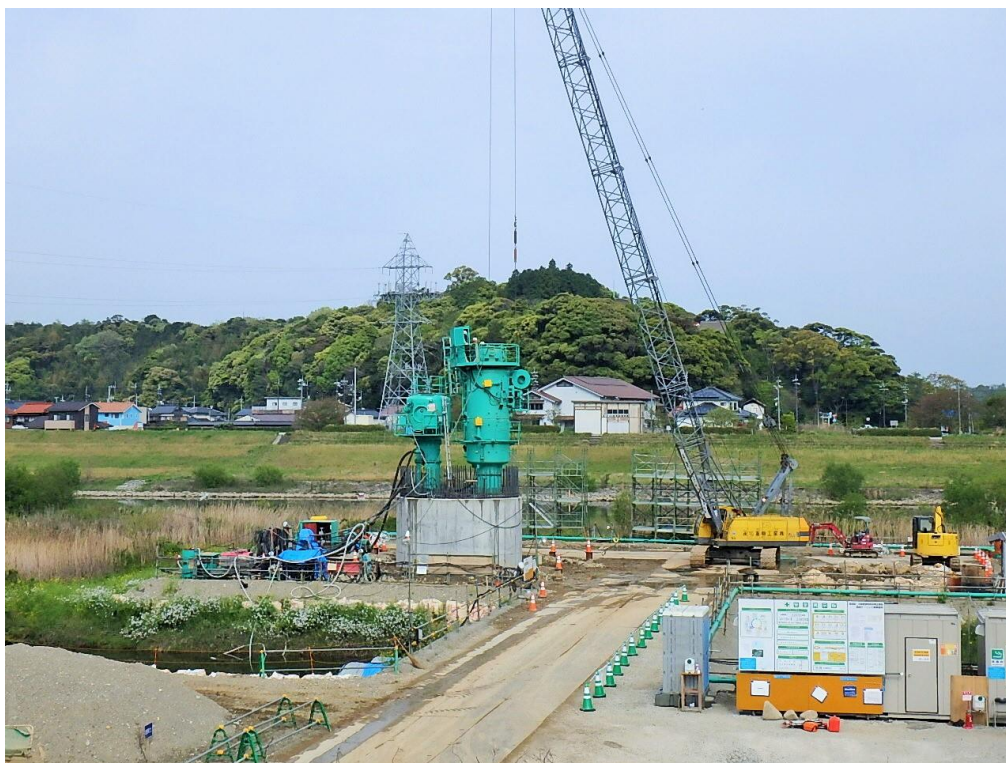
【 都市計画道路元町人麿線の施工状況 】
