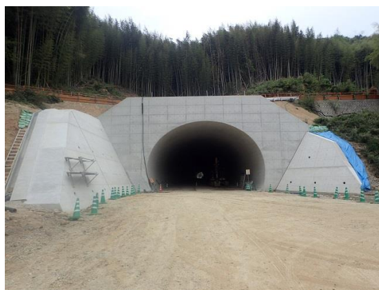
【 新木部トンネルの施工状況 】
