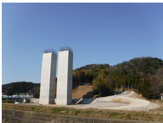
【 新津田川橋の施工状況 】
