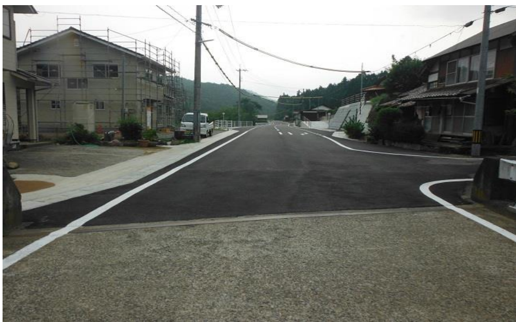
【 一般県道美濃地石見横田停車場線の施工状況 】
