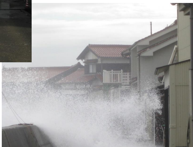
【 小浜海岸における越波の状況 】
