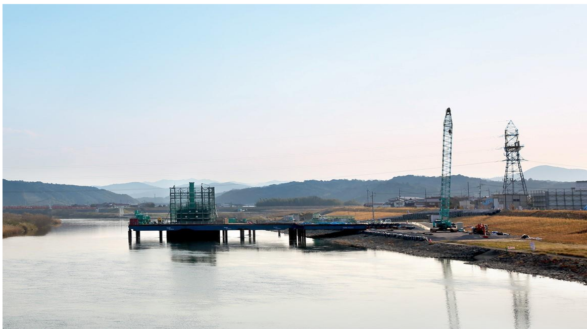
【 都市計画道路元町人麿線の施工状況 】
