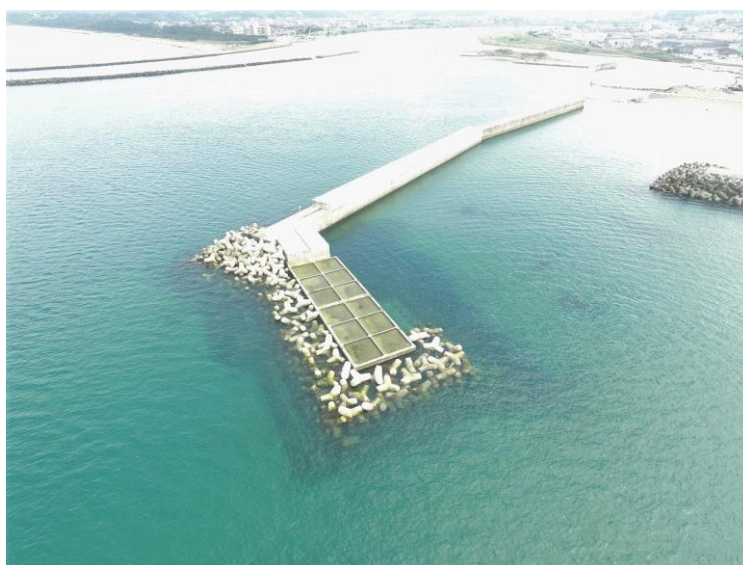
【 益田港の施工状況 】
