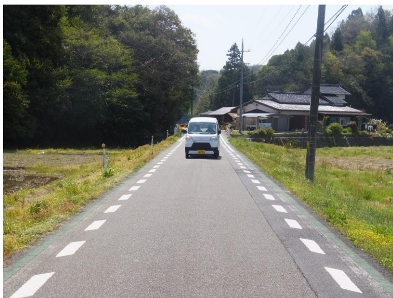
【 一般県道美濃地石見横田停車場線の状況 】
