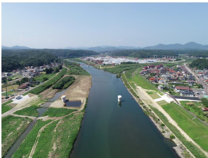
【 都市計画道路元町人麿線の施工状況（新高角工区） 】
