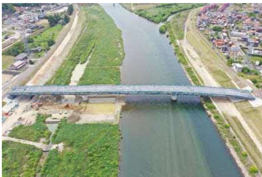
【都市計画道路元町人麿線の施工状況】
