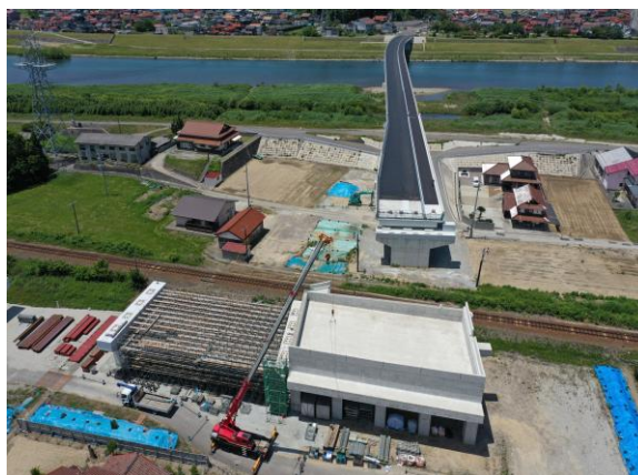
【須子高架橋の状況】
