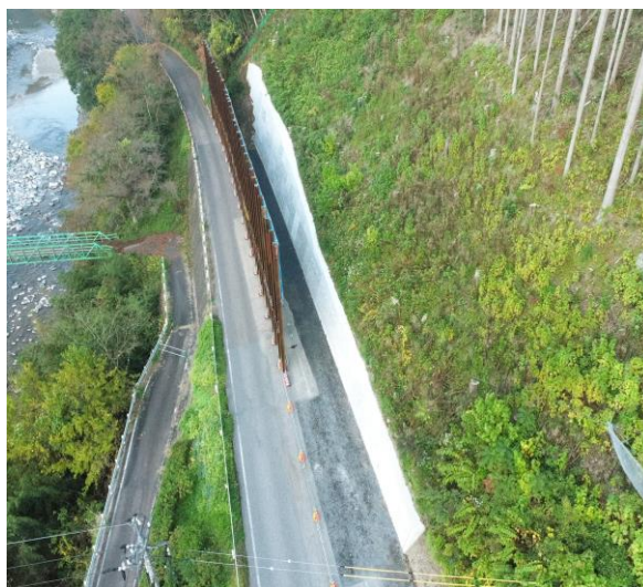
【澄川工区の状況】
