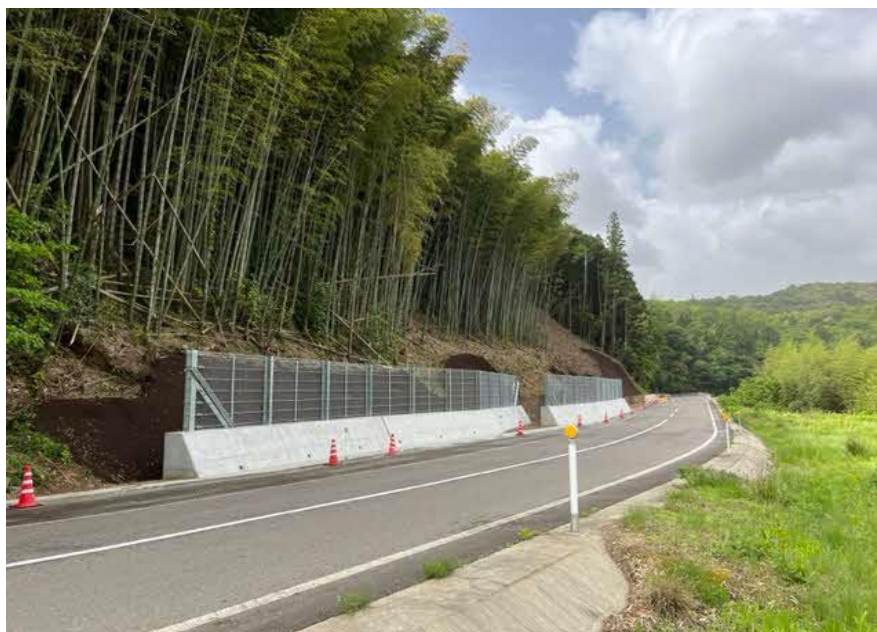
【一般県道美濃地石見横田停車場線の状況】
