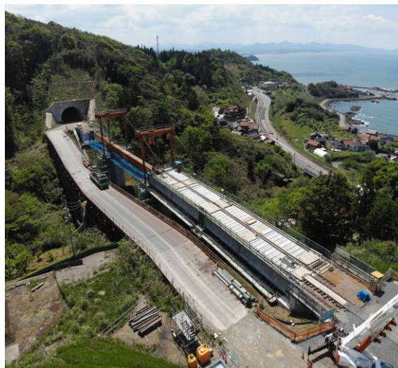
【大浜第2高架橋外 PC 上部工事の状況】
