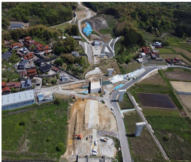
【遠田 IC 第3改良工事の状況】
