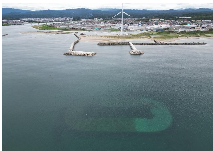
【益田港の施行状況】
