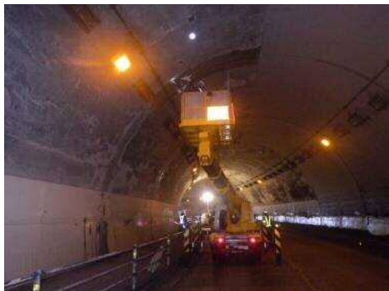
写真 3-1 FRP ネット設置状況
