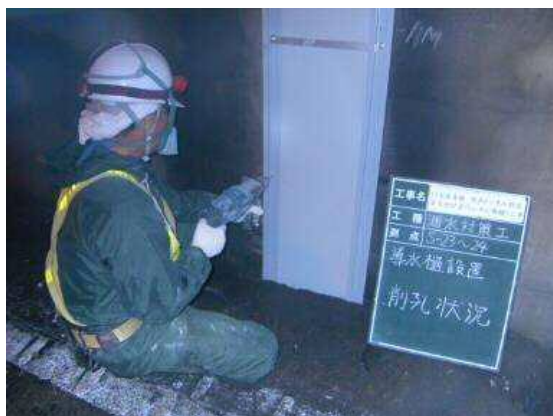
写真 3-2 線導水工
