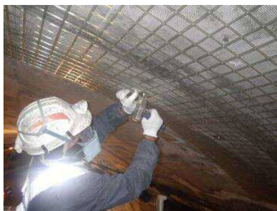
写真 3-1 FRP ネット設置状況
