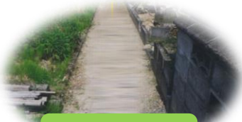
排水路の設置
