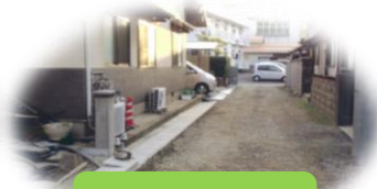
砂利道を舗装
