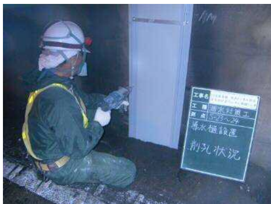
写真 3-2 線導水工
