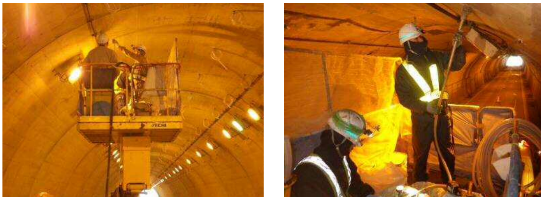
写真 3-4 裏込注入状況
