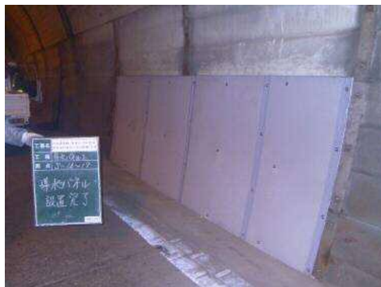
写真 3-3 面導水工
