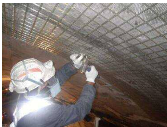
写真 3-1 FRP ネット設置状況
