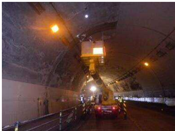
写真 3-1 FRP ネット設置状況
