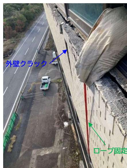
○ 外壁落下防止緊急対策工事の実施状況
