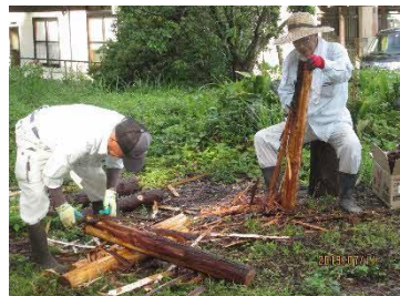
遺跡見学路の階段設置作業
