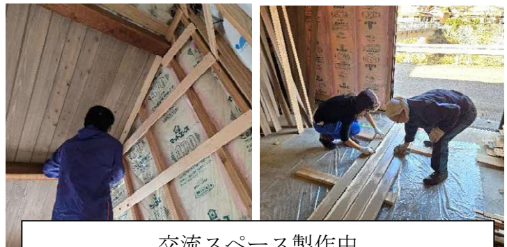
交流スペース製作中
