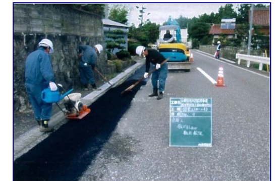
図 11 再生資材による工事
