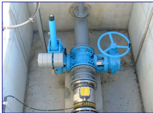
図 5.6 緊急遮断弁
