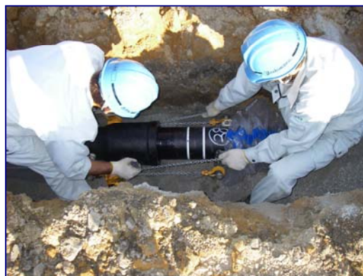
図 5.5 耐震化の工事状況
