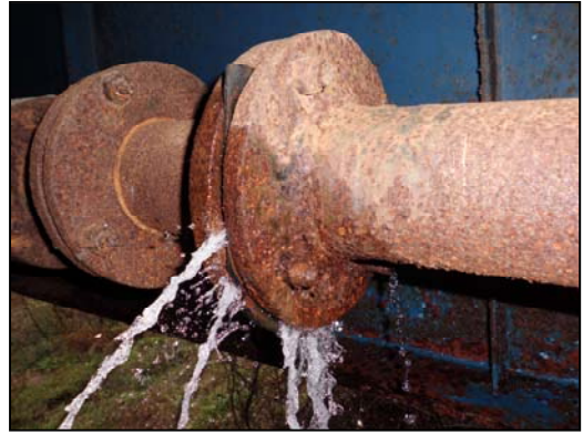
図 3.9 漏水の写真
