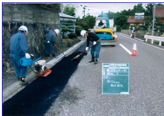
図 5.16 再生資材による工事
