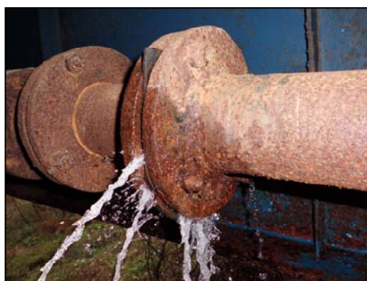
図 3.9 漏水の写真
