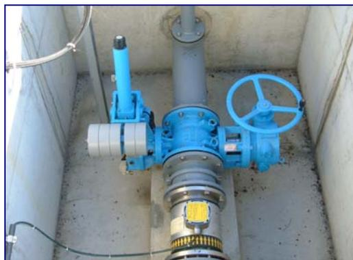
図 5.6 緊急遮断弁
