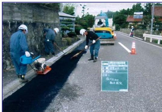
図 5.16 再生資材による工事
