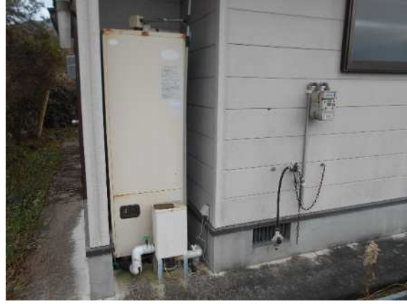
ボイラー、タンク、ブroom
