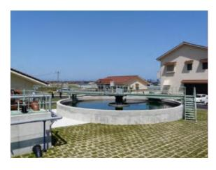
手前が紫外線最終沈殿池、奥左が管理棟、右が機械棟
