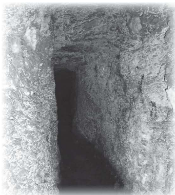
蟠竜湖疎水。岩盤を約200mくり抜く大変な工事でした。
