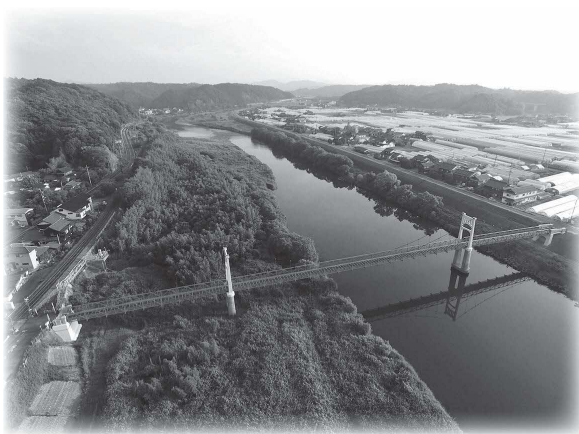
高津川と飯田吊橋
