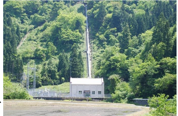
【匹見発電所本館】
