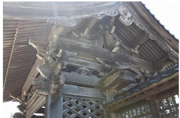
【小屋組の大瓶束や笈型で棟木を支える】
