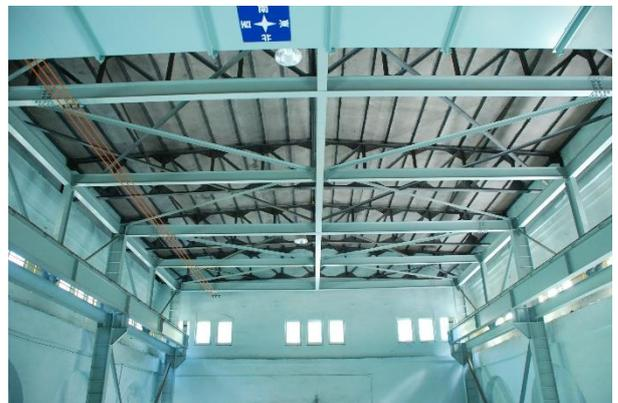
【鉄骨のトラスフレームで屋根を支える】
