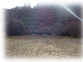
基礎砕石、搬入！
