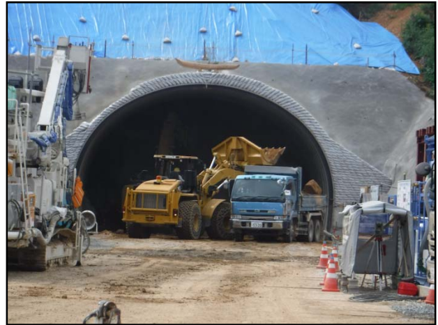
工事現場の状況2（近景）
