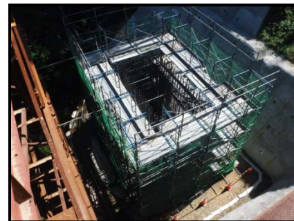
工事現場の状況 (古市場第2高架橋下部第2工事)
