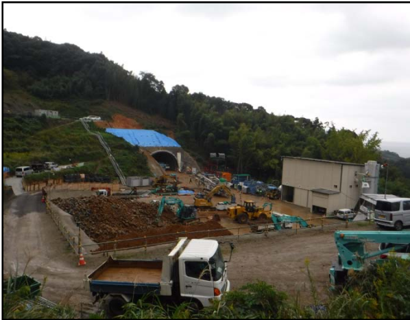
工事現場の状況1（遠景）
