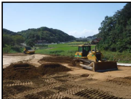
工事現場の状況 (上古市地区改良外工事)
