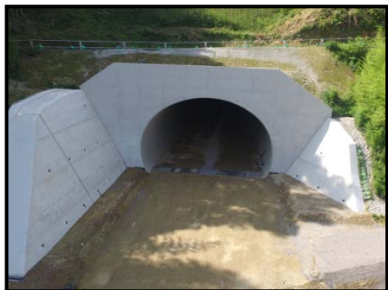
工事現場の状況 (新木部トンネル工事)
