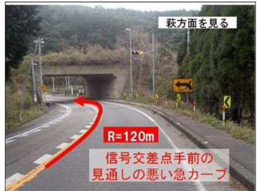
写真① 線形不良箇所・益田市飯浦町付近
