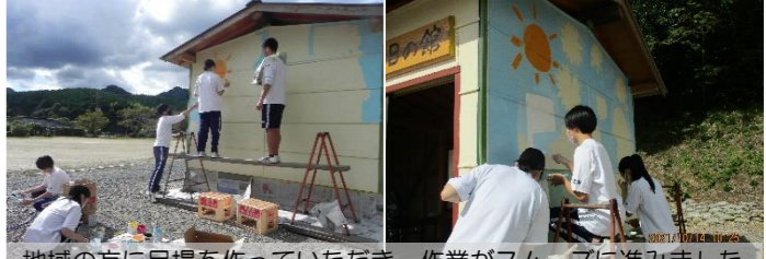
地域の方に足場を作っていたいただき、作業がスムーズに進みました。
