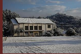
雪の元美濃小学校屋体
