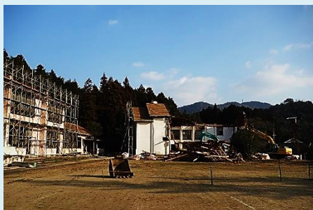
1月23日現在の解体工事状況
