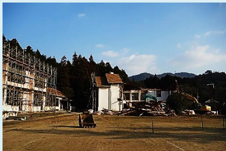
1月23日現在の解体工事状況
