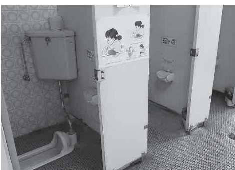
急がれるトイレ改修
