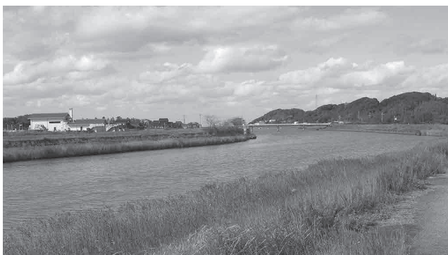
中須雨水排水ポンプ場と益田川
