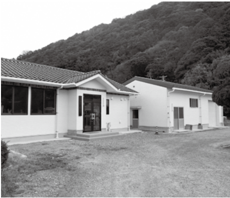
制御監視室の耐震化を行った益田水源地
