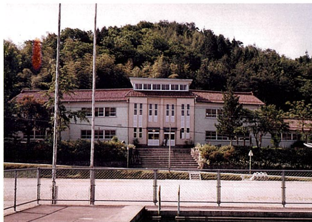
当時、二川中学校として建てられた校舎(昭和41年～昭和59年)
