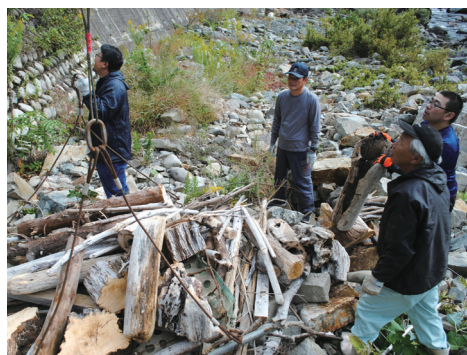
クレーンを使った流木撤去作業の様子 4tの流木を撤去しました (匹見川・亀ヶ淵)
